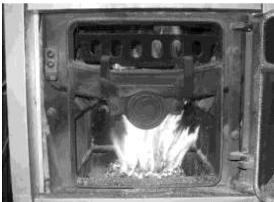
Obr. č. 22 Optimální tvar plamene
